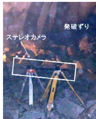
写真-5 現場でのステレオカメラ撮影状況
